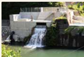
梶原町小水力施設
